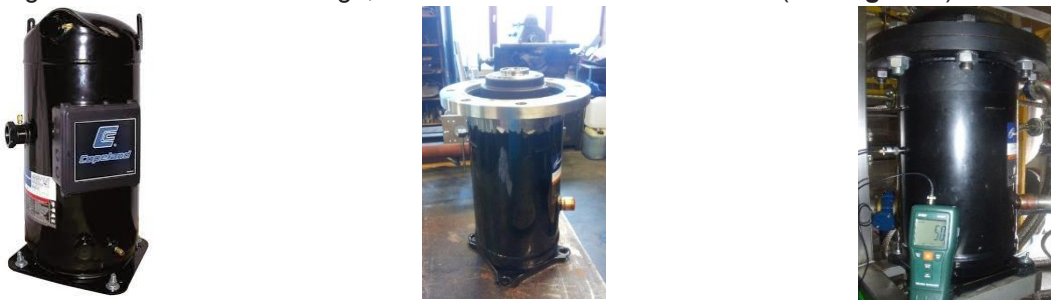
Figure 2 : Transformation d'un compresseur spirale (gauche) en turbine (droite)
