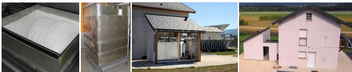
Figure 9 : Vues de l'installation - De gauche à droite : un étage de réacteur en cours de remplissage, un réacteur complet avant isolation, le local de stockage en cours d'installation (2 réacteurs sur 5 présents), la maison expérimentale avec l'appentis dédié au stockage.
